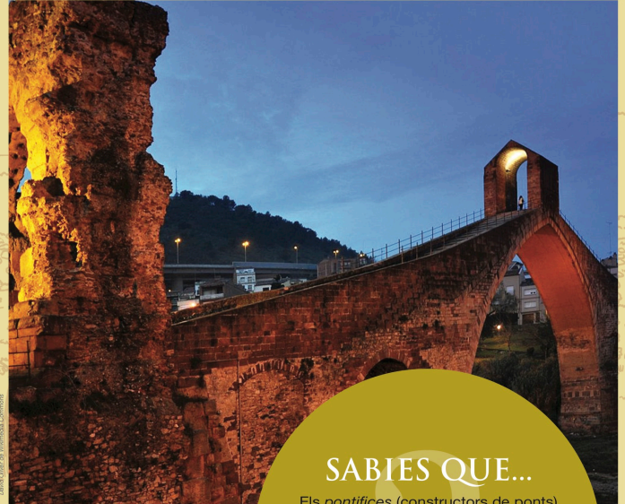
Pont de Martorell
